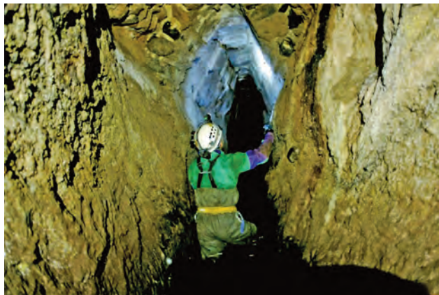
Un tratto del tunnel durante una ispezione speleologica del 2015
