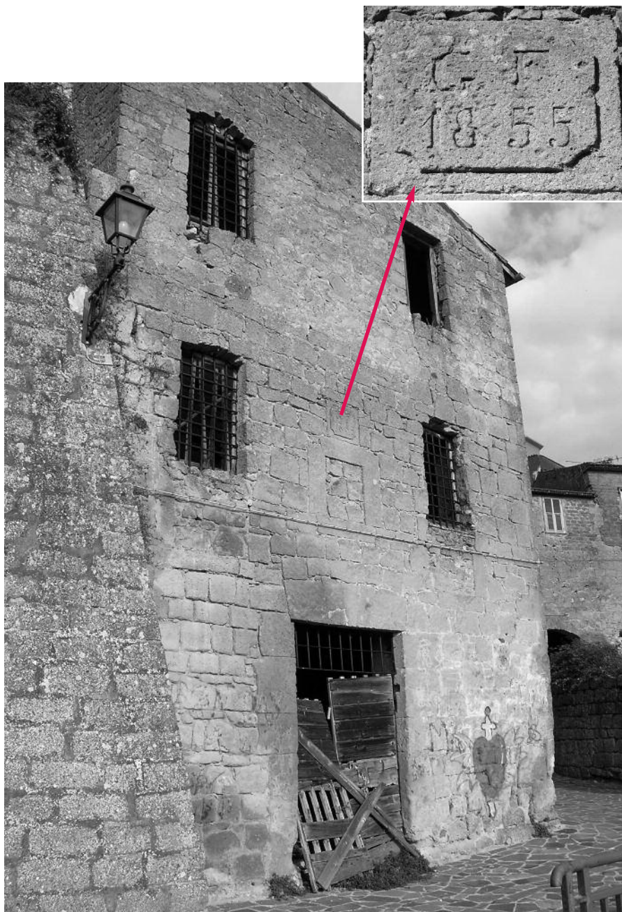
Imponente fabbricato in tufo su tre livelli in Via Valleforma, adibito in passato ad ampia stalla e rimesse di fieno poi diventate magazzini. Su un blocchetto murato al centro della facciata sono elegantemente incise ed incorniciate le lettere "G.F." e l'anno di costruzione "1855". Sono le iniziali di Giuseppe Fabrizi (1796-1870), padre del maestro-poeta Luigi, che infatti all'impianto del catasto "italiano" del 1876 ne risulta intestatario insieme con la sorella Maria, quali eredi del "fu Giuseppe". I due erano comproprietari di diversi altri locali contigui, con accesso dai piani superiori di via degli Orti e confinanti con la proprietà De Parri, tanto che la definizione catastale dell'edificio della foto, registrato anch'esso nella via degli Orti, è "casa in costruzione sopra un preesistente piano".
