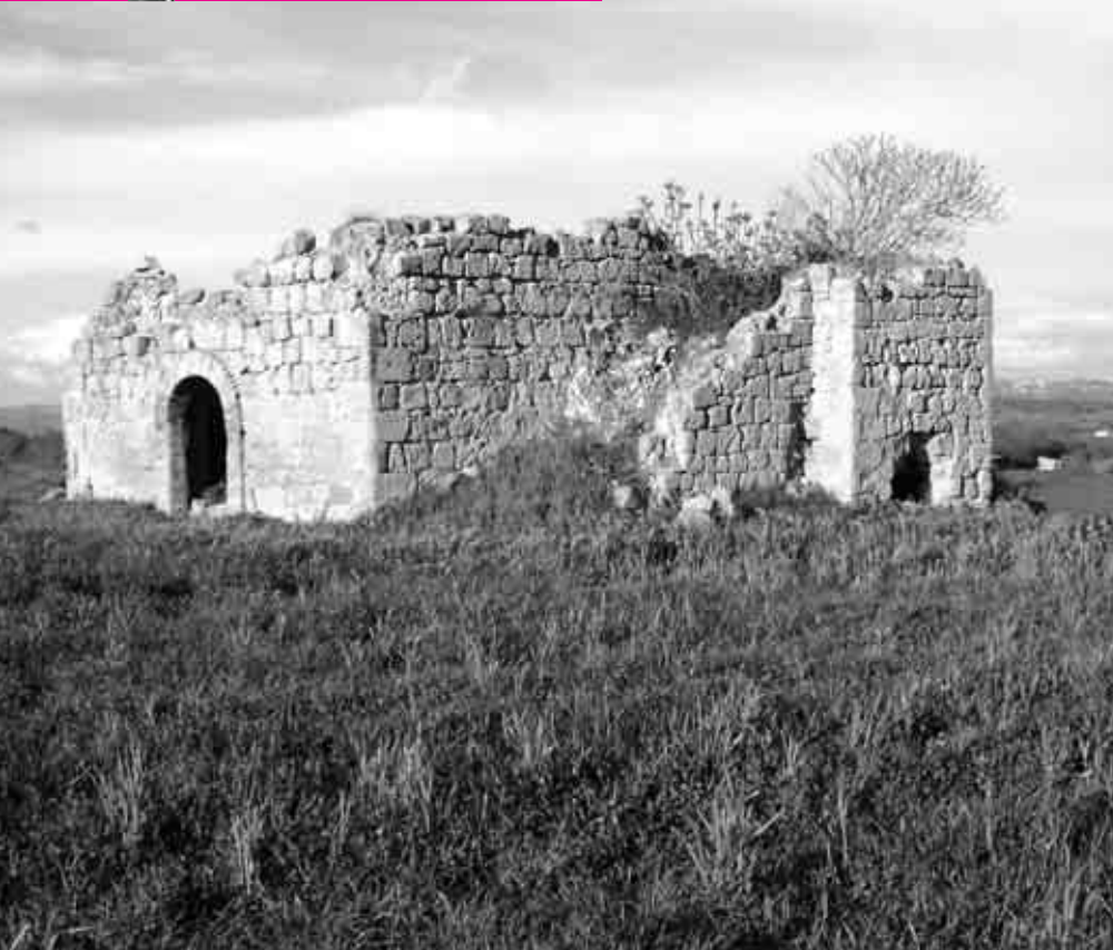
Il casale del Giraldo come si presenta oggi (prospetto sud-ovest).
