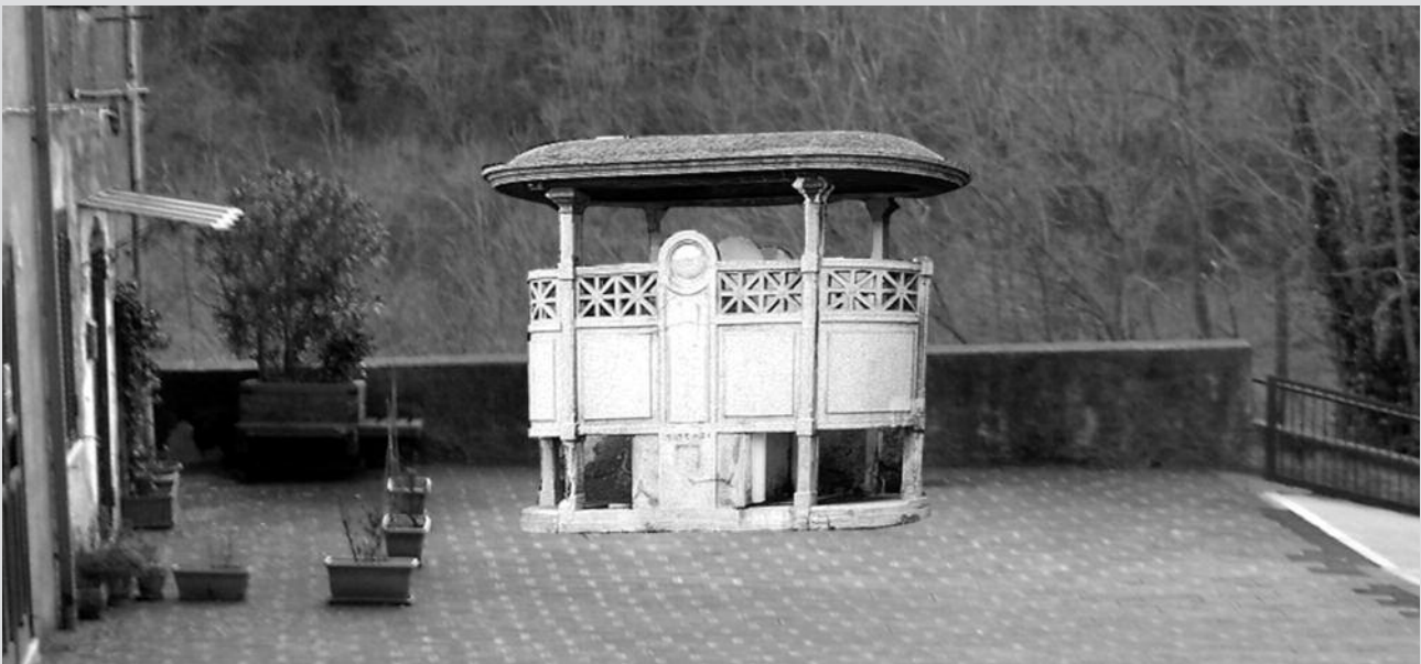
Ricostruzione mediante fotomontaggio del vespasio installato alla Poggetta . Il “chiosco-orinatoio, ‘tipo Como’, in pietra artificiale, a due posti (smontabile)”, era prodotto dalla ditta Umberto Renzi di Torino e aveva le dimensioni di m. 2,70 x 1. “È costruito in soli 6 pezzi - vantava la pubblicità - quindi robustissimo e di facile montaggio. Viene pressato e ricavato da forme in ferro, particolare di massima importanza che da nessun’altra Ditta del genere è adottato”. Oltre a questo, era stato ricavato un orinatoio a più posti nel piccolo ambiente alla base della torre civica
